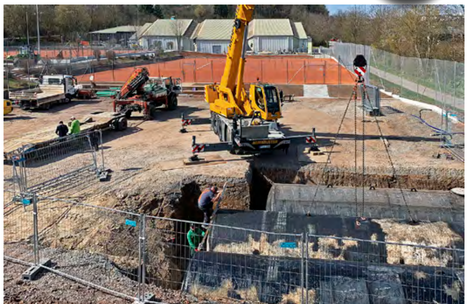
Einbau der großen Zisterne im Batterieverbund
