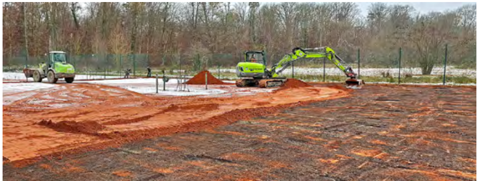
Erdarbeiten bei frostigen Temperaturen
