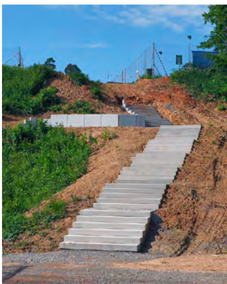
Die neue Treppenanlage im Bau (Fertigstellung und Hangbegrünung in Kürze)
