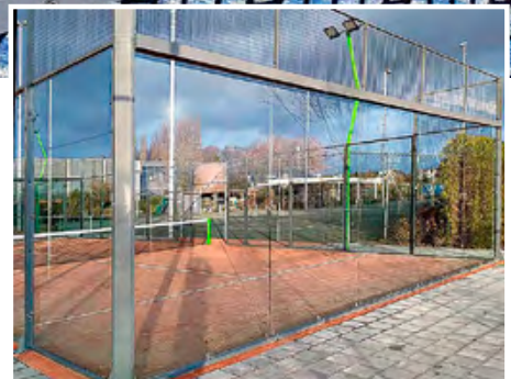
Courtwände aus VSG-Glas bieten hohe Sicherheit und volle Transparenz für spannende Matches
