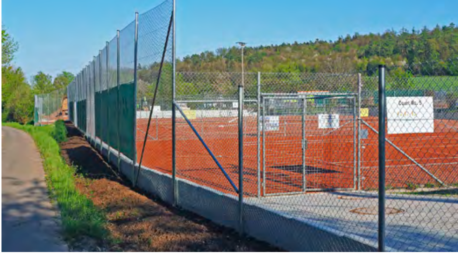
Erhöhte Mauerseiben an Platz 5–8, dazu neue Zauneinfassungen entlang der gesamten Anlage
