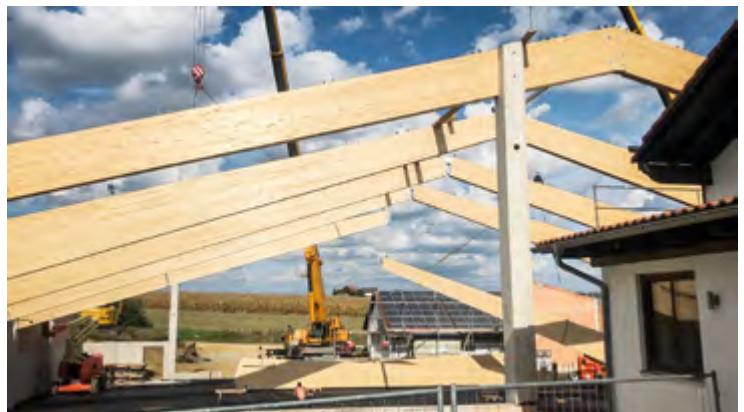
Die Ahamer Halle im Bau und ...
